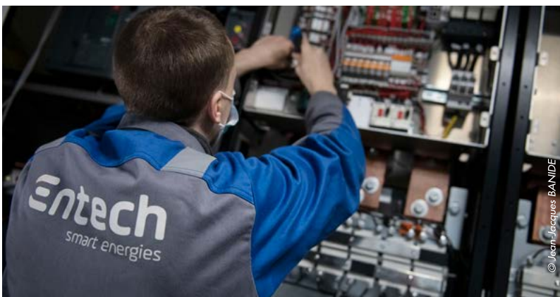
Assemblage d'une armoire électrique.
