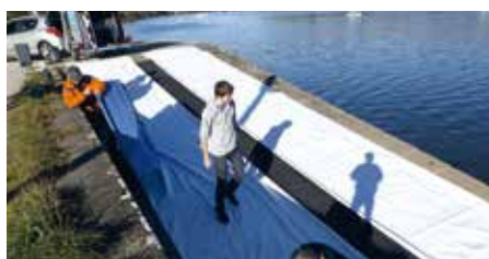
Mise en place du système CarenEcolo sur une cale (bâches de récupération et zone d'échouage)
