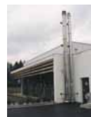
Chaufferie bois à Rosporden.
