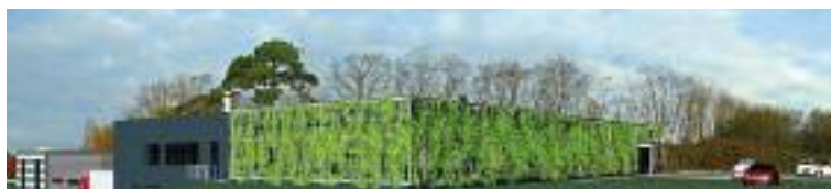
Façade principale de la pépinière des innovations, Creac'h Gwen, Quimper.
